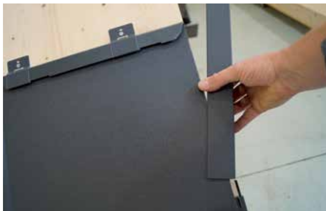
11 Ortgangelement am Abschluß einsetzen und ...
