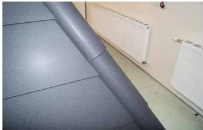
13+14 Die Dachplattenstöße sind je nach Bedarf auszuschneiden.
