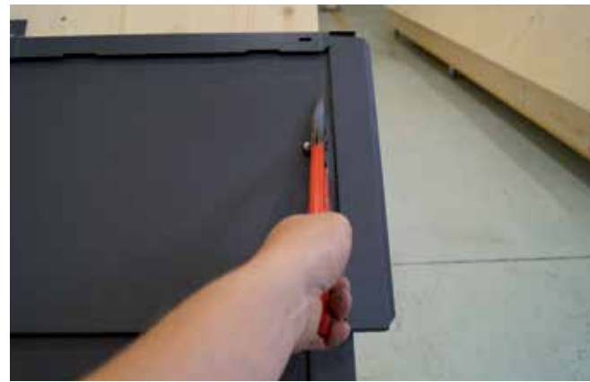
10 Nächste Dachplatte bündig mit der Dachkonstruktion
