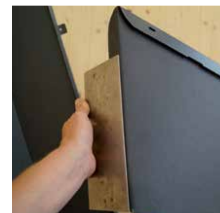
1 bis 6 3 cm Umschlag - mit Umschlageisen umbiegen!
