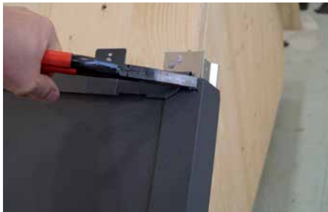
7+8 Haltetasche mit Flachzange aufbiegen.
