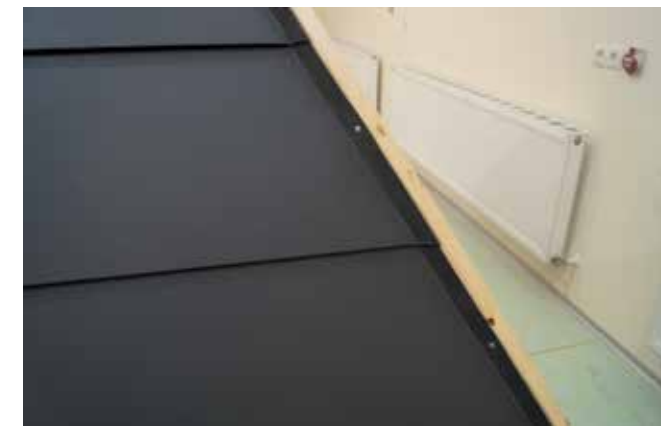
9 Jede Platte ist an der Gratlatte ausnahmslos mit Rillennägeln aus dem Lieferprogramm zu befestigen.
