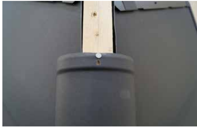
11 Die Firstkappe ist oben mit einem Rillennagel und ...
