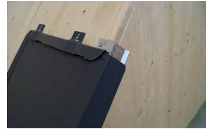
14 ... und mit Rillennägeln befestigen.
