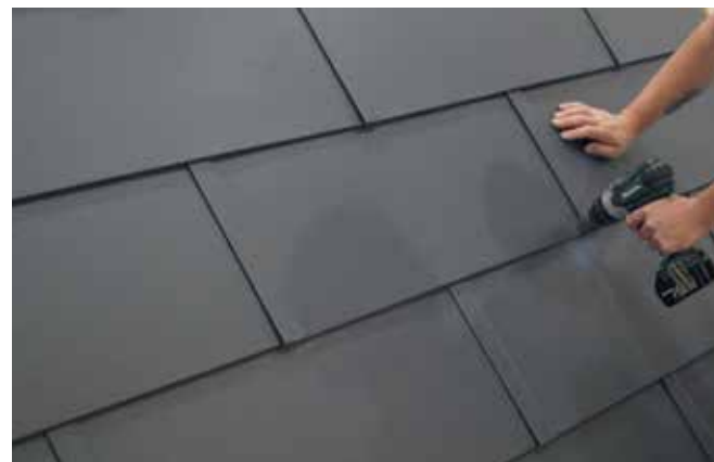
24 ... und rechts mit einer Niete befestigen.
