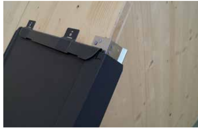
6 ... und mit Rillennägeln befestigen.
