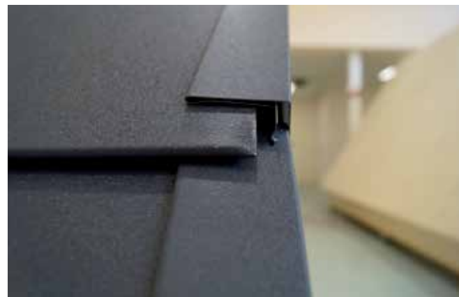
12 ... an der aufgebogenen Lasche einhängen.
