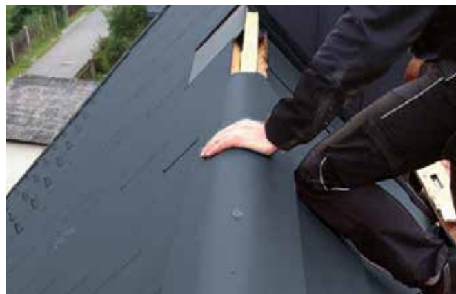
3 Lüfterfirst mit mitgelieferten Dichtschrauben befestigen.
