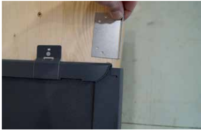
5 Befestigungsklammer einsetzen ...
