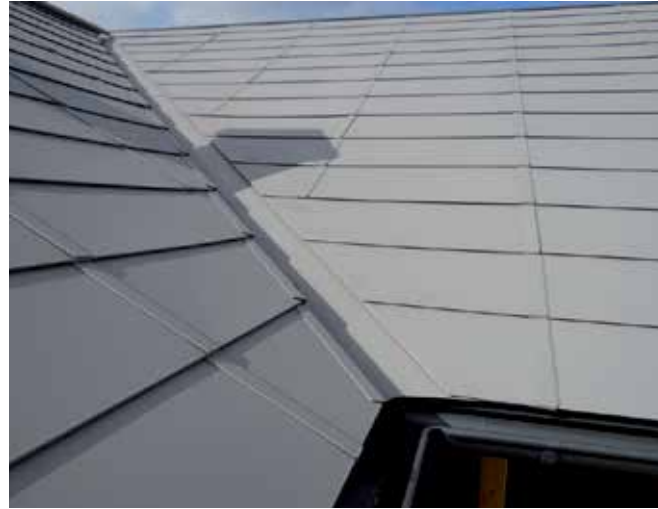
Verlegung in Kassettenform
