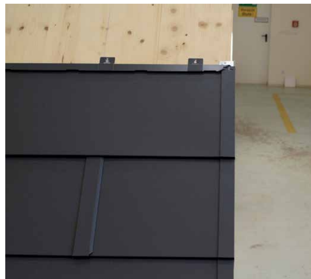
15+16 Haltetasche mit Flachzange aufbiegen.
