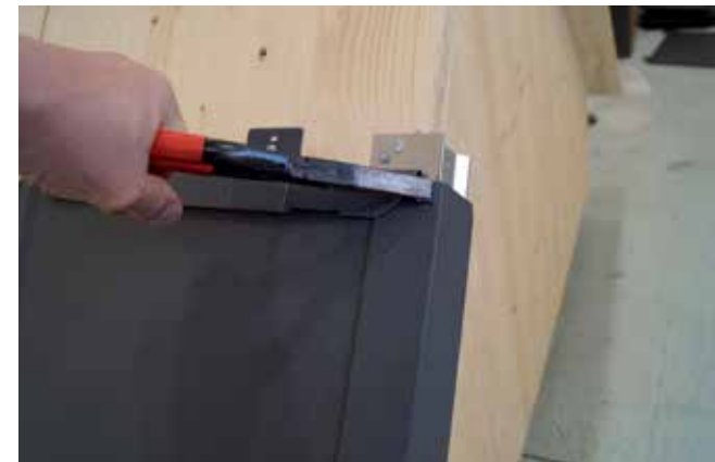
15+16 Haltetasche mit Flachzange aufbiegen.
