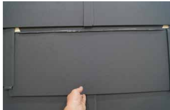
20 ... in die Seitenfälze einfügen und nach oben schieben.
