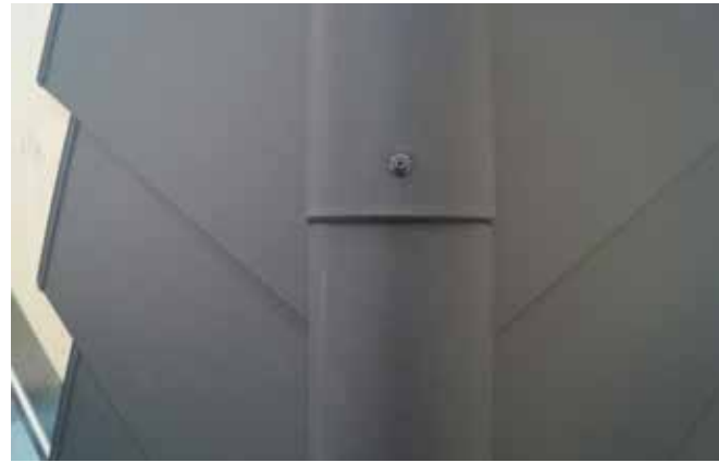
12 ... unten mit dem mitgelieferten Dichtschrauben zu befestigen.
