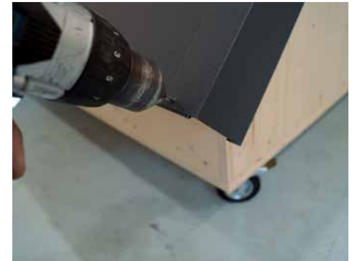
2 Erstes Ortgangelement wird mit Nieten fixiert.
