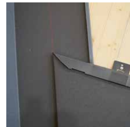
1 bis 6 3 cm Umschlag - mit Umschlageisen umbiegen!
