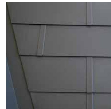
1 bis 6 3 cm Umschlag - mit Umschlageisen umbiegen!
