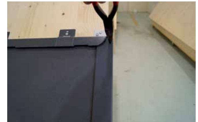
14 ... und mit Rillennägeln befestigen.
