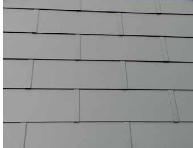
Verlegung im Halbversatz
