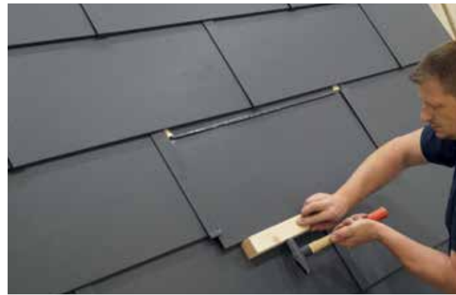
22 Eventuell mit Holzklötz und Hammer nachschlagen.
