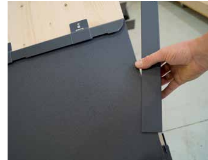
1 Ortgangelement einsetzen.
