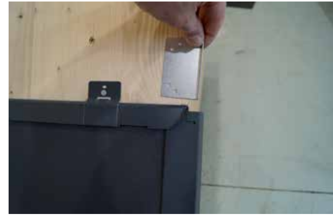
13 Befestigungsklammer einsetzen ...
