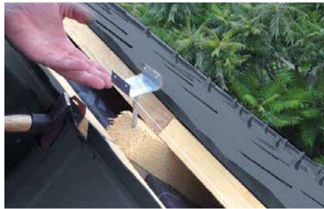
1+2 Letzte Platte 3 cm aufstellen - Firstlattenhalter mit Schnur montieren.
