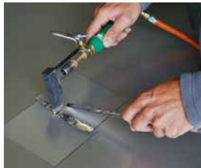
Wiederholen bis die Lötnaht fertiggestellt ist.
