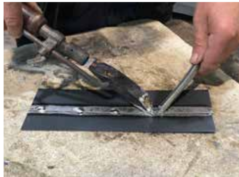
Zinn auf Heftpunkt übertragen und Naht zusammenpressen.
