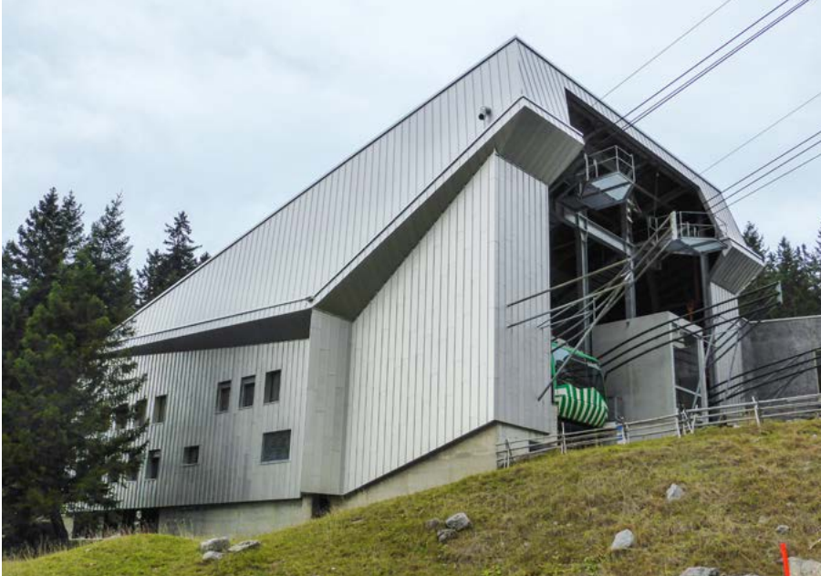
Die kantige, elegant wirkende Talstation im neuen Kleid aus Roofinox Pearl.
