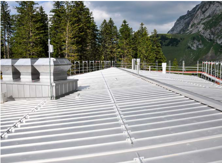
Das attraktive Dach mit spezieller Geometrie und aus ChromNickelStahl Roofinox Pearl wurde spengler-technisch sauber bedeckt.
